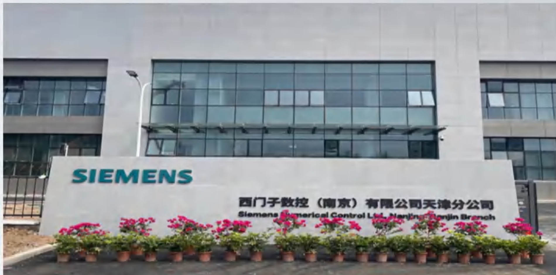
西门子数控（南京）有限公司天津分公司项目
